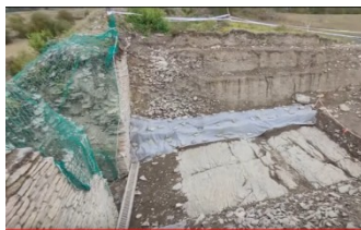
2023. Qark. Alboko atea. Eskabadora arkaitzeraino Puerta lateral, la excavadora hasta la roca Porte latérale, l'excavateur jusqu'au rocher
